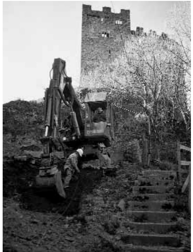
Abb. 3. Wartau, Gretschins. Bau einer Kanalisationsleitung unterhalb der Burg Wartau. Foto KA SG.
